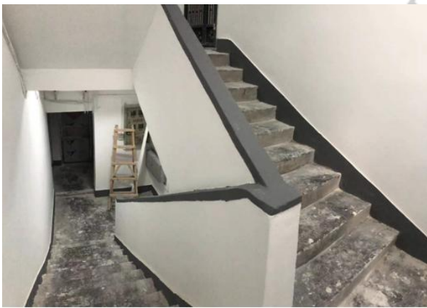
1D-2-1-3 墙面、楼梯栏板维修改造
