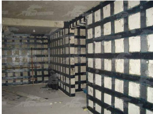
1D-1-1-3 碳纤维布加固 (钢筋混凝土柱、墙)
