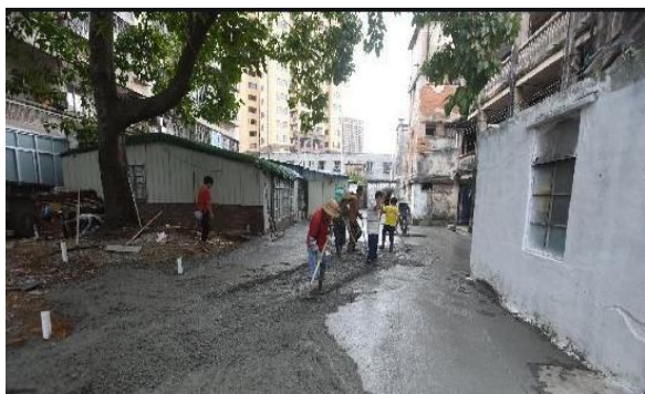
2D-1-1-1 混凝土路面加铺
