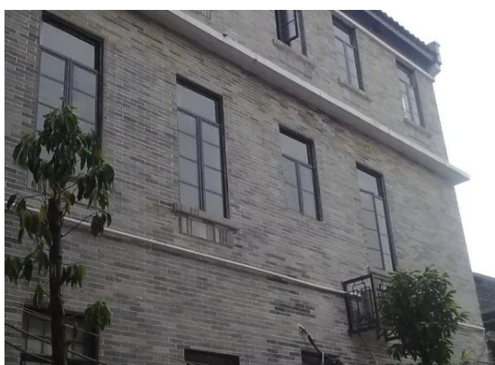
5D-3-1-1 仿古砖墙（柱）面
