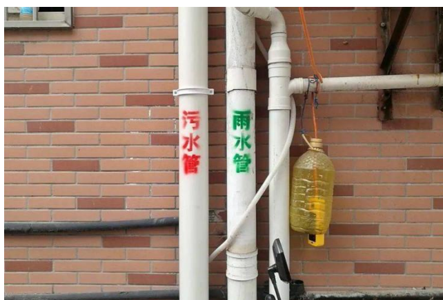
1D-7-2-1 更换雨水管
