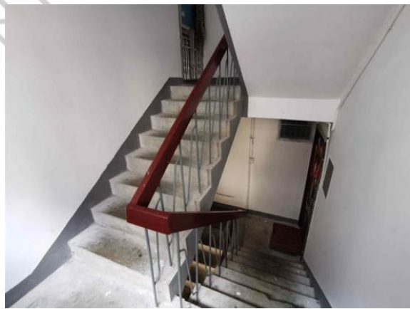
1D-2-1-4 栏杆、扶手维修改造
