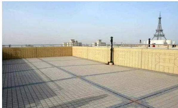
1D-4-1-2 屋面女儿墙内面升级改造
