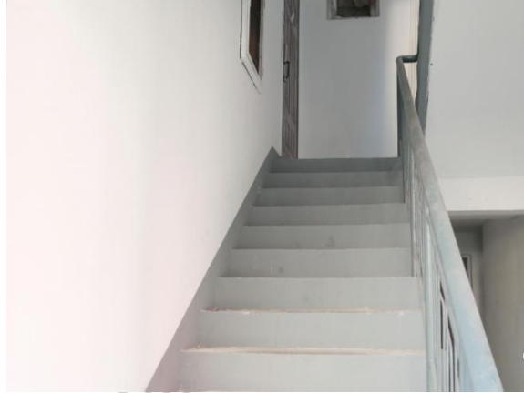
1D-2-1-2 地面、梯级维修改造
