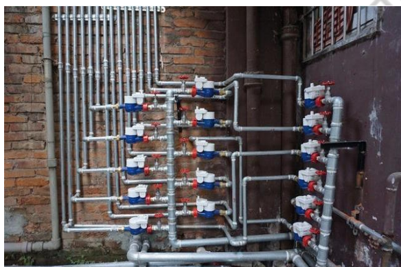
1Z-7-1 建筑物楼栋内公共区域给水 系统改造（集中安装）
