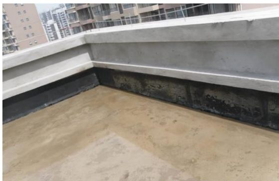
1D-4-1-1 屋面女儿墙内面维修改造
