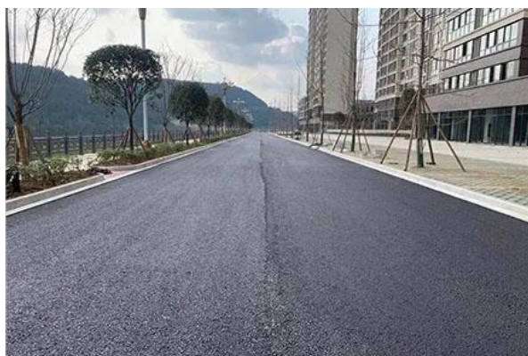
5Z-1-1 片区道路改造（沥青道路）
