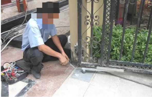
3D-1-2-1 拆除原有大门
