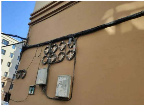
1Z-7-4 电信、电视、网络三线整治 (原线路整理绑扎)
