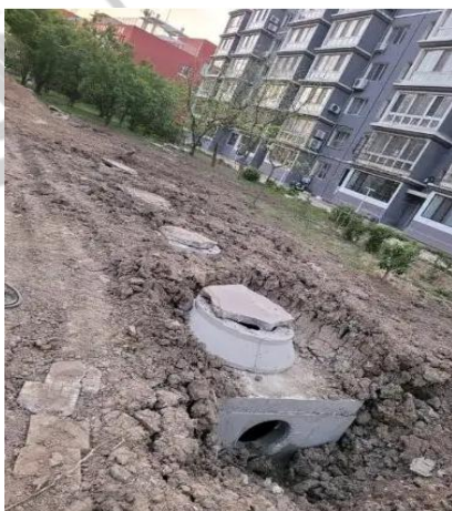
2D-2-4-1 钢筋混凝土化粪池
