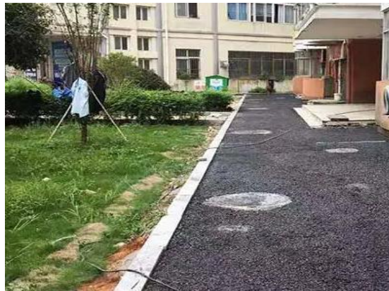
2D-1-2-5 路缘石（混凝土）
