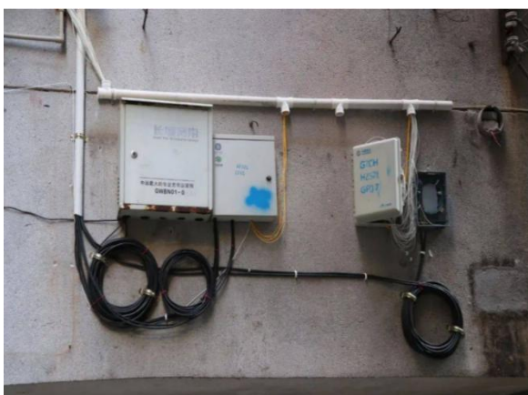
1Z-7-5 电信、电视、网络三线整治 (拆卸原有线路后放入线管或线槽内)
