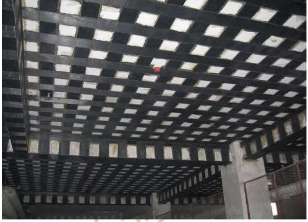
1D-1-2-2 碳纤维布加固 (钢筋混凝土梁、板)
