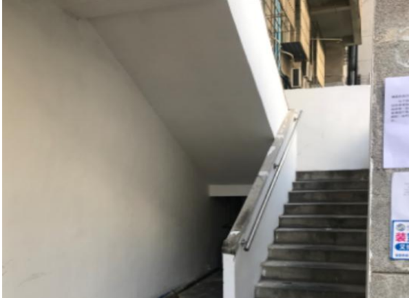
1D-2-1-1 天棚维修改造
