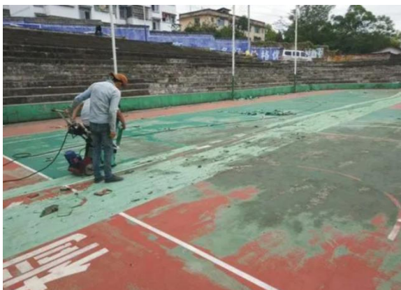
4D-1-1-1 原有户外小型多功能球类运动场地及设施（拆除）
