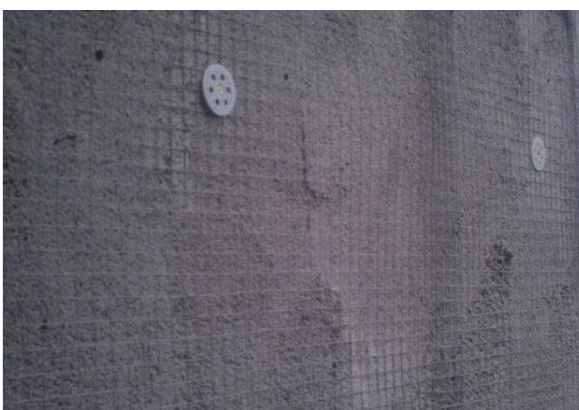
1Z-4-2 外墙保温改造
