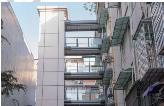
1D-6-1-1 电梯廊桥延长段（半封闭型）
