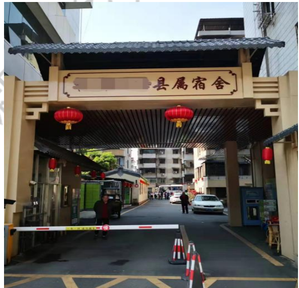
3D-1-2-4 钢结构牌坊
