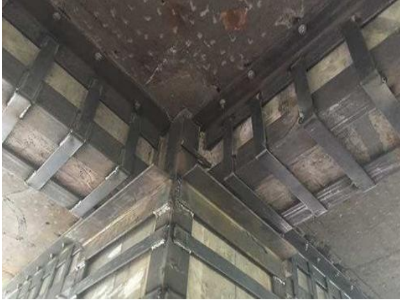
1D-1-2-1 钢材加固 (钢筋混凝土梁、板)
