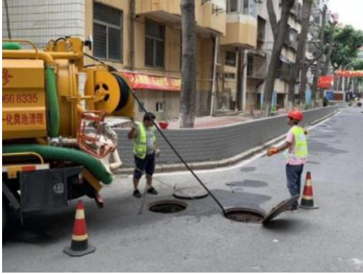
2D-2-3-1~2D-2-3-3 排水管道清淤
