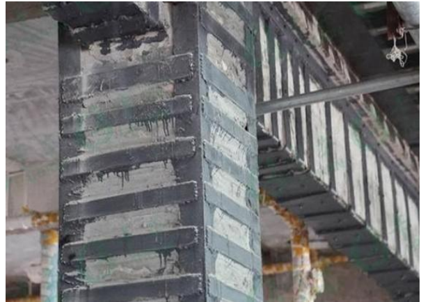
1D-1-1-2 钢材加固 (钢筋混凝土柱、墙)
