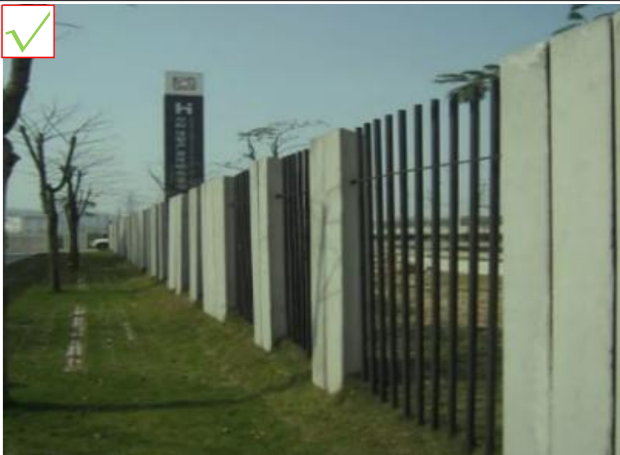
围墙结合栏杆设置，通透性好
