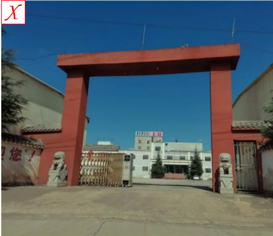
大门与工厂建筑风貌不吻合
