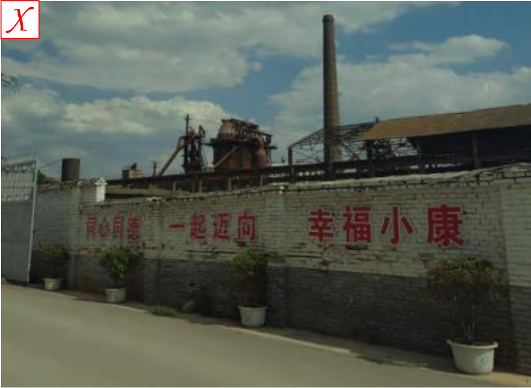
实体围墙简陋、通透性差
