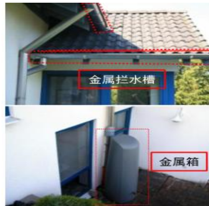
简易的家庭集雨罐，分流器依靠手动控制
